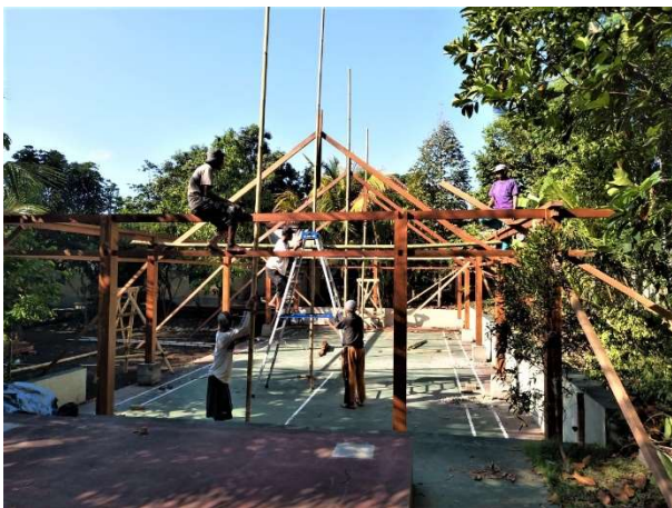
Start der Bauarbeiten «Überdachung Yoga-Platz»
