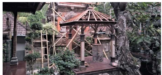
Reparaturarbeiten am Haupttor
