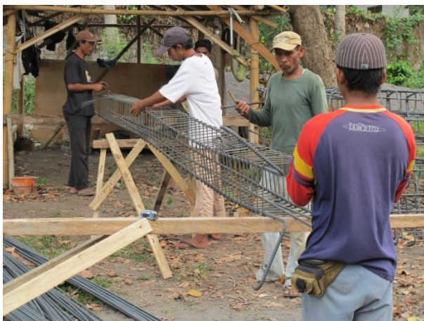
Eisen für die Betonarbeiten wird gebogen und zusammengefügt
