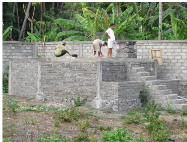
Das Wasserreservoir und die Umfriedung sind bereits erstellt
